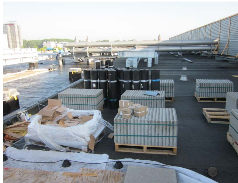
Te hoge belasting op een stalen hal, een 'bouwprocesrisico' dat kan en moet worden voorkomen.**
