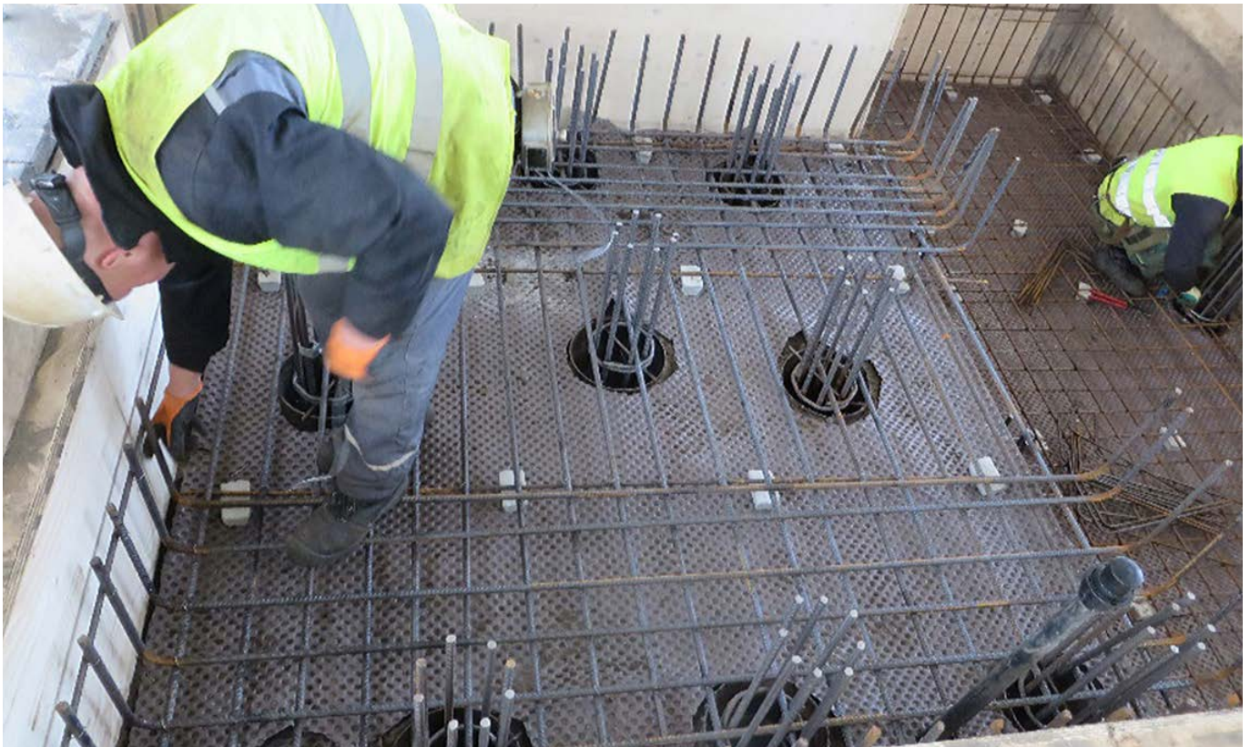
Inspectie funderingspalen. De Wkb eist onafhankelijke beoordeling.**
